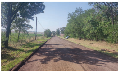
Oprava komunikace II/416 Žabčice-Pohořelice
