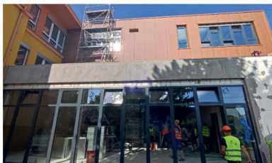
Přístavba budovy základní školy
