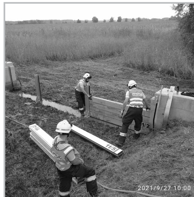
Stavba protipovodňových zábran
