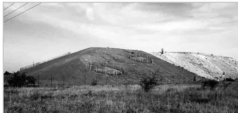
Rekulivovaná část skládky v Žabčicích
