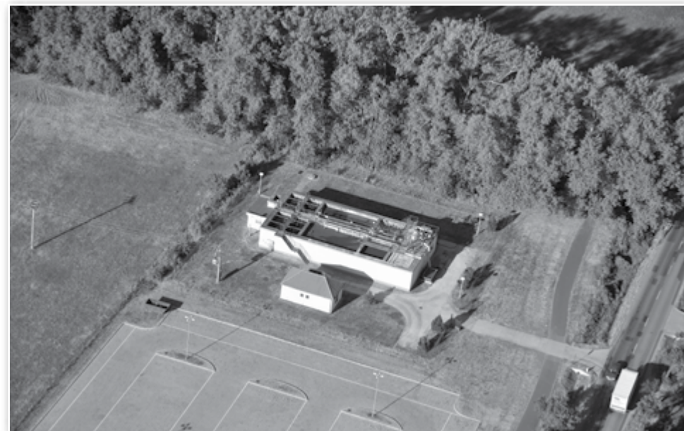
Čistírna odpadních vod Žabčice, Unkovice, Přísnovice
