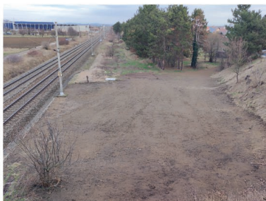
Stav po demolici nádražního domku
