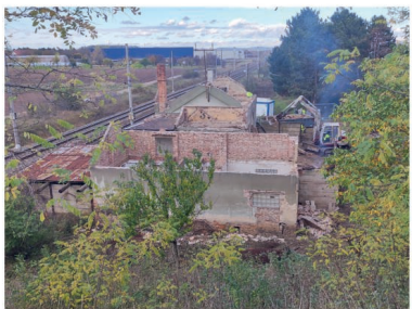
Demolice nádražního domku
