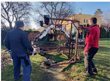
Demolice již nevyhovujícího dětského hřiště (lod')
