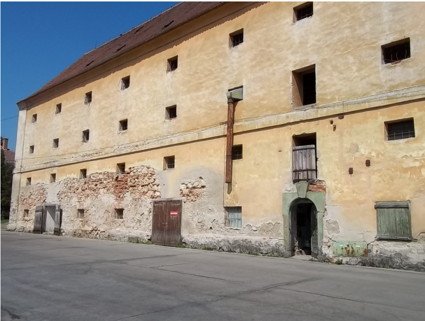
JIŽNÍ FASÁDA - SOUČASNÝ STAV
