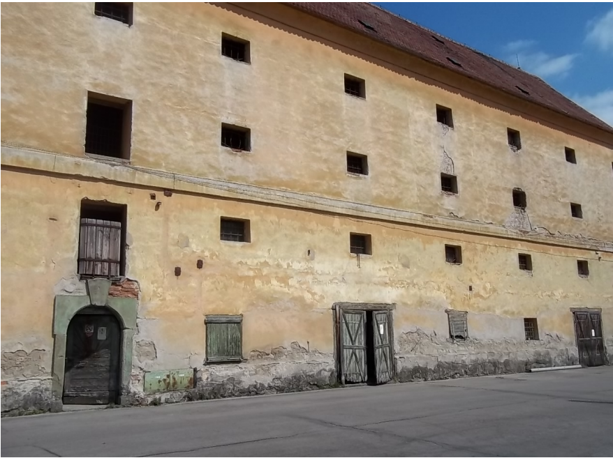
JIŽNÍ FASÁDA - SOUČASNÝ STAV
