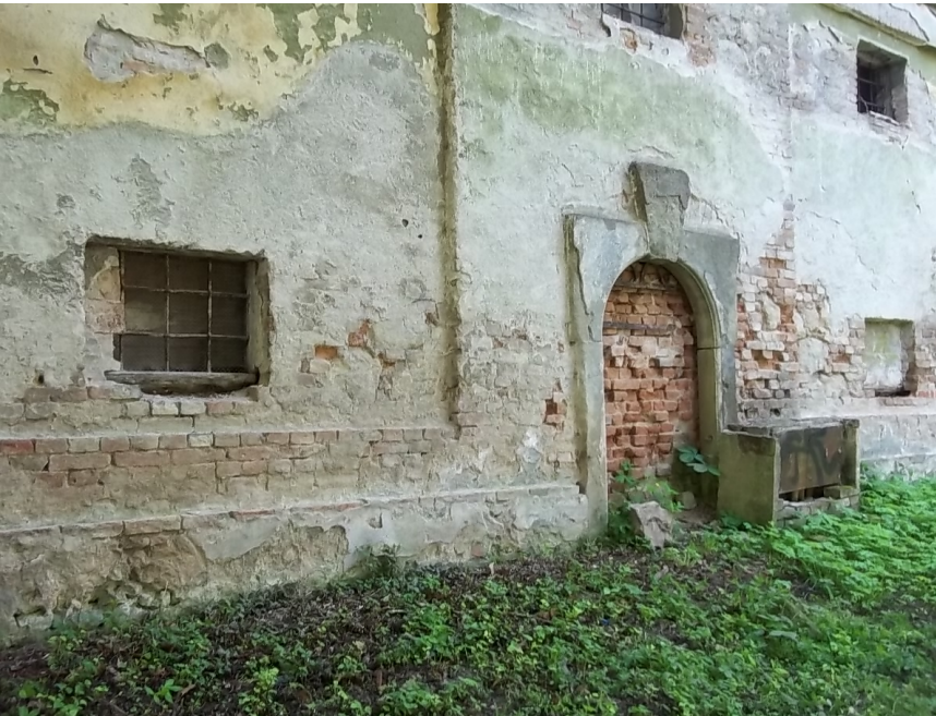
POHLED NA SEVERNÍ VSTUPNÍ PROSTOR
